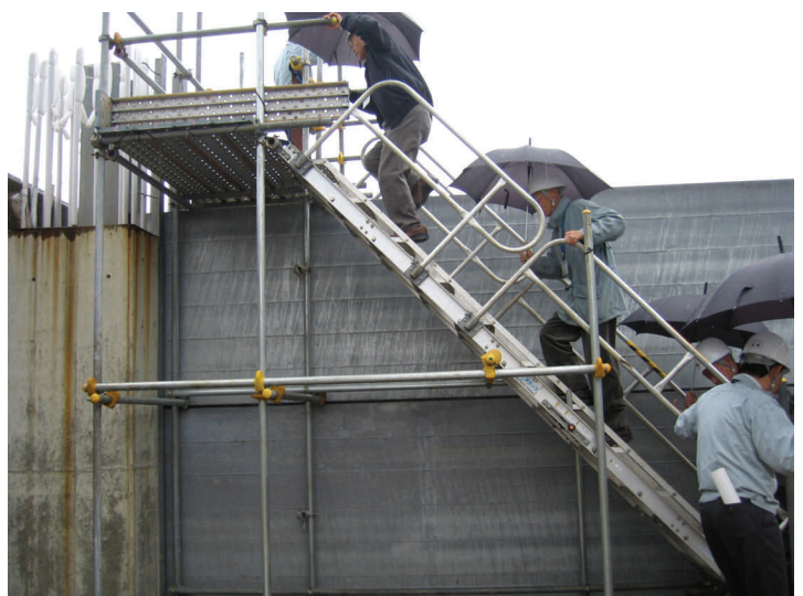
6.1mにかさあげされた壁(写真正面)が津波を防いだが、貫通部やピットから津波が浸入した。
